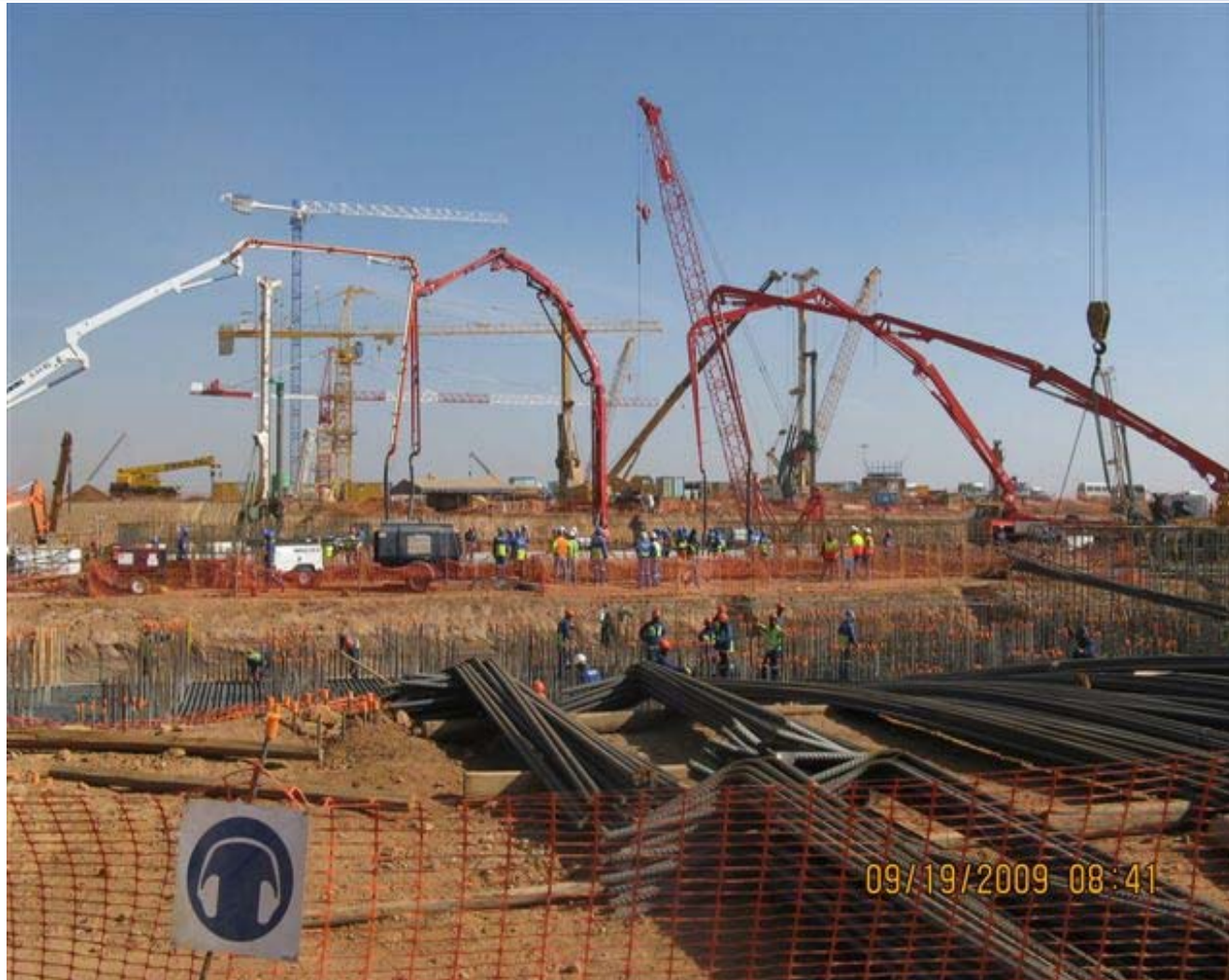
Pouring Pile Cap – Unit 1 Boiler
